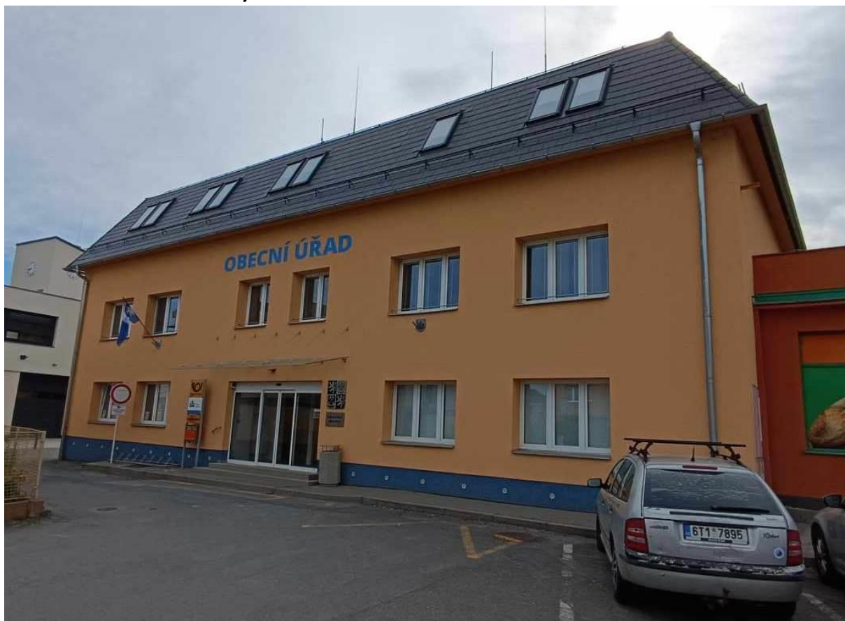
Obrázek 19 Zrekonstruovaný obecní úřad
