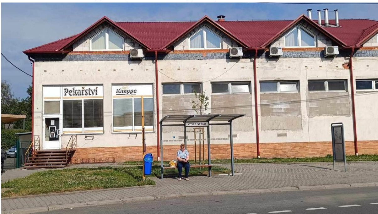
Obrázek 16 Pekárna Knappe - chybí bezbariérový přístup
