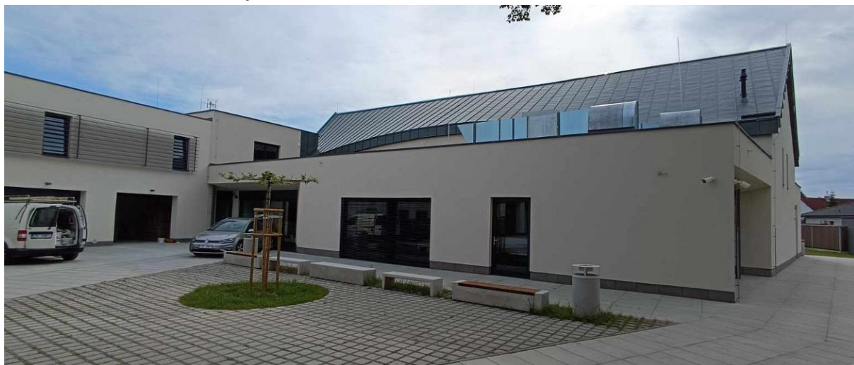
Obrázek 18 Zrekonstruovaný Kulturní dům - Multifunkční dům Otice
